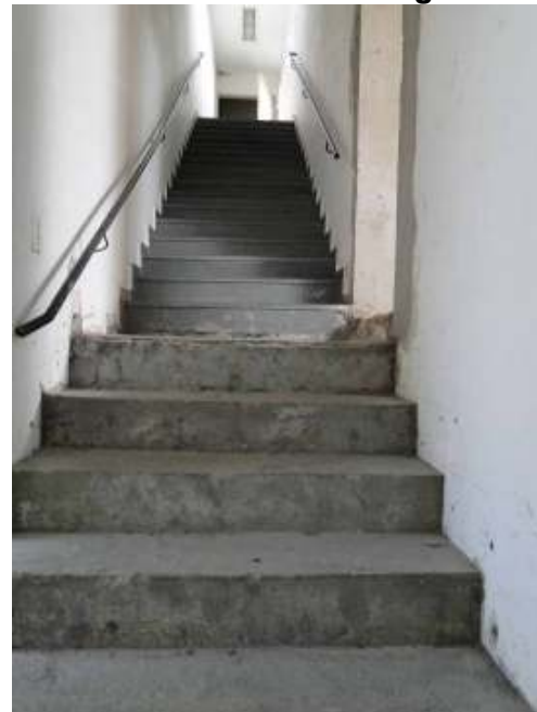
Escada Acesso Área Administrativa CÉU
