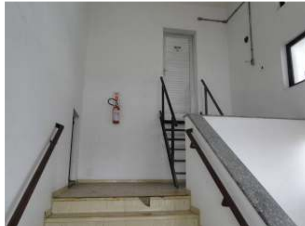
Escada padrão Bloco C
