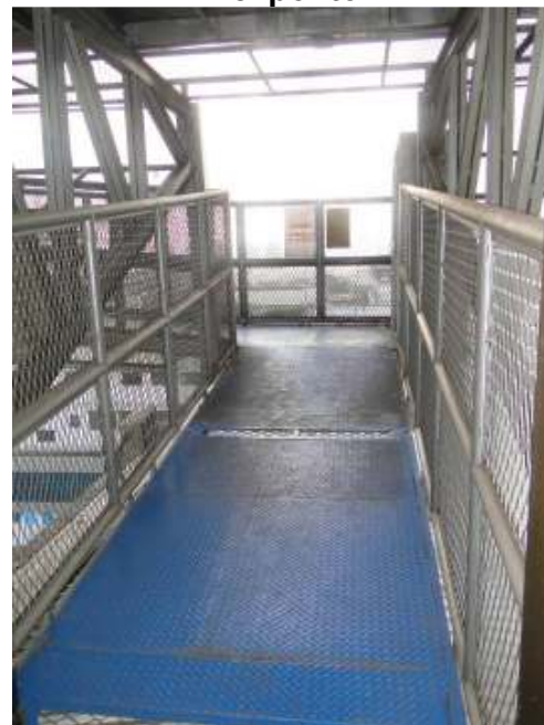
Rampa de Acesso ao Heliponto
