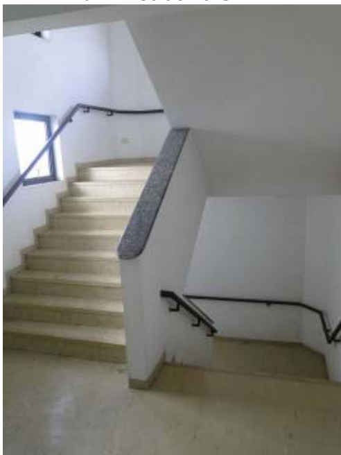
Escada padrão Bloco C
